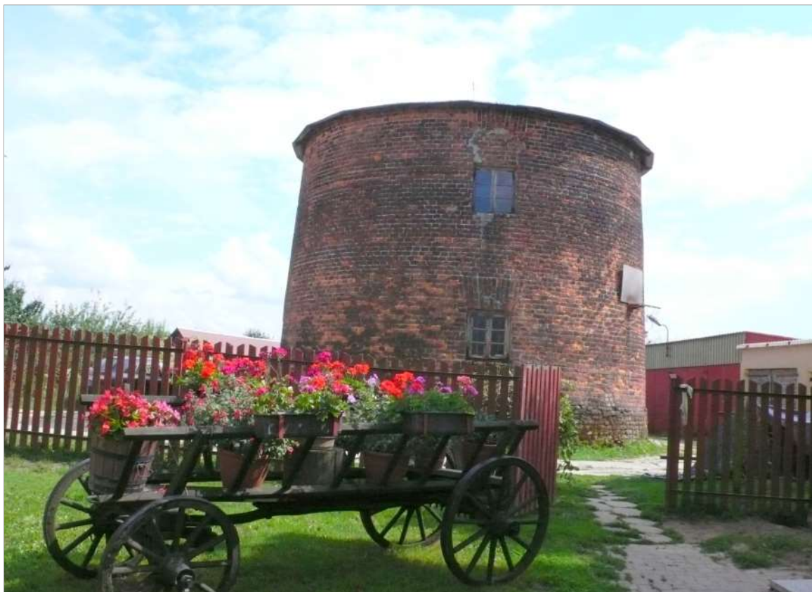
Zdjęcie 6. Wiatrak murowany „holender” w Piotrowicach Wielkich.
